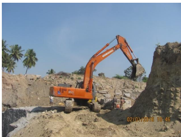
Fig 3.3:a) Hydraulic Excavator LC 330
