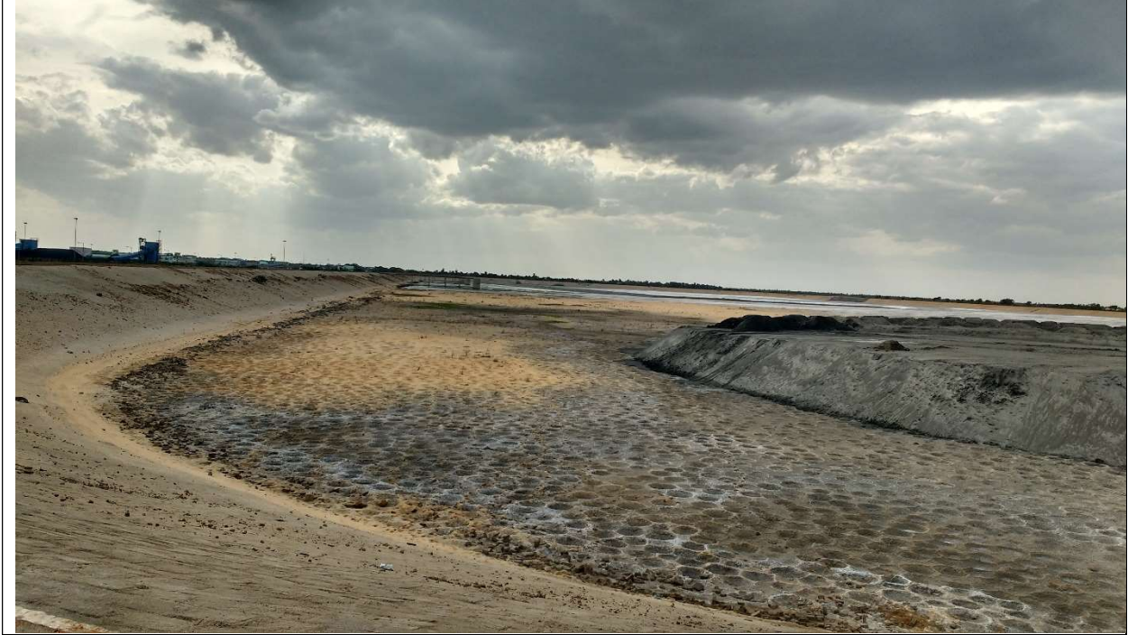
9. Ashpond of Sembcorp Thermal Powe Plant.
