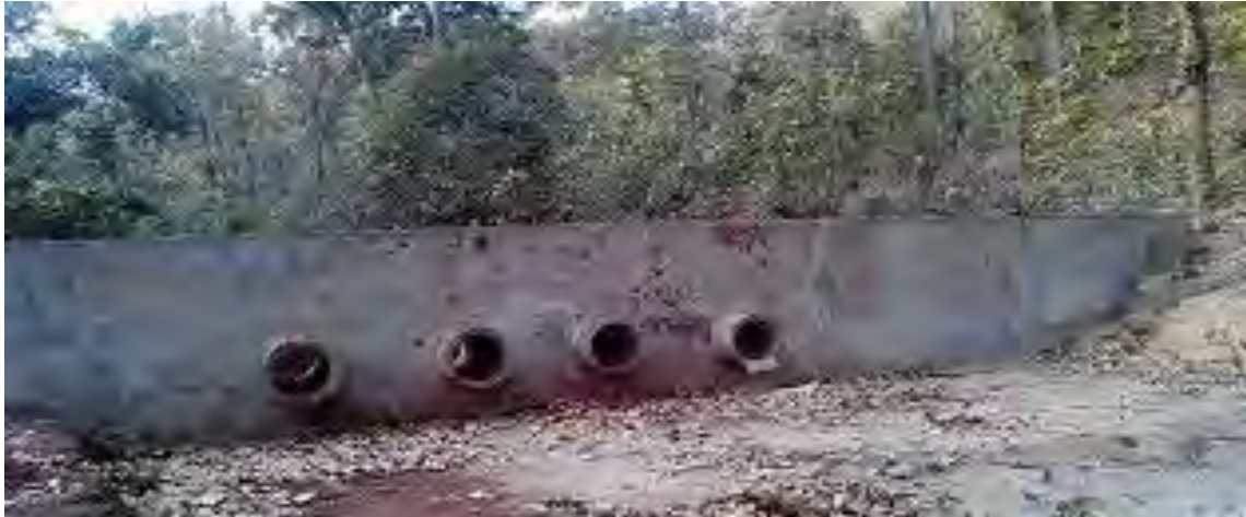
Fig.4.5: Check Dam across the Najkura Nalla (Kalta Block)
